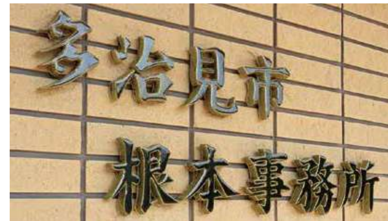
落下防止や壁面から陶文字を浮かせる際のボルト埋込加工、位置合わせ用の原寸型紙も作成します。
