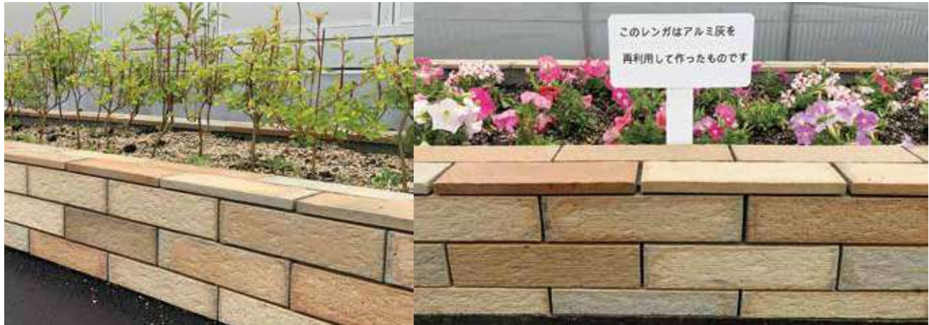
ダイニチ株式会社 岡山工場／アルミニウムを溶解する際の副産物である「アルミ灰」を再利用したリサイクルタイル。
