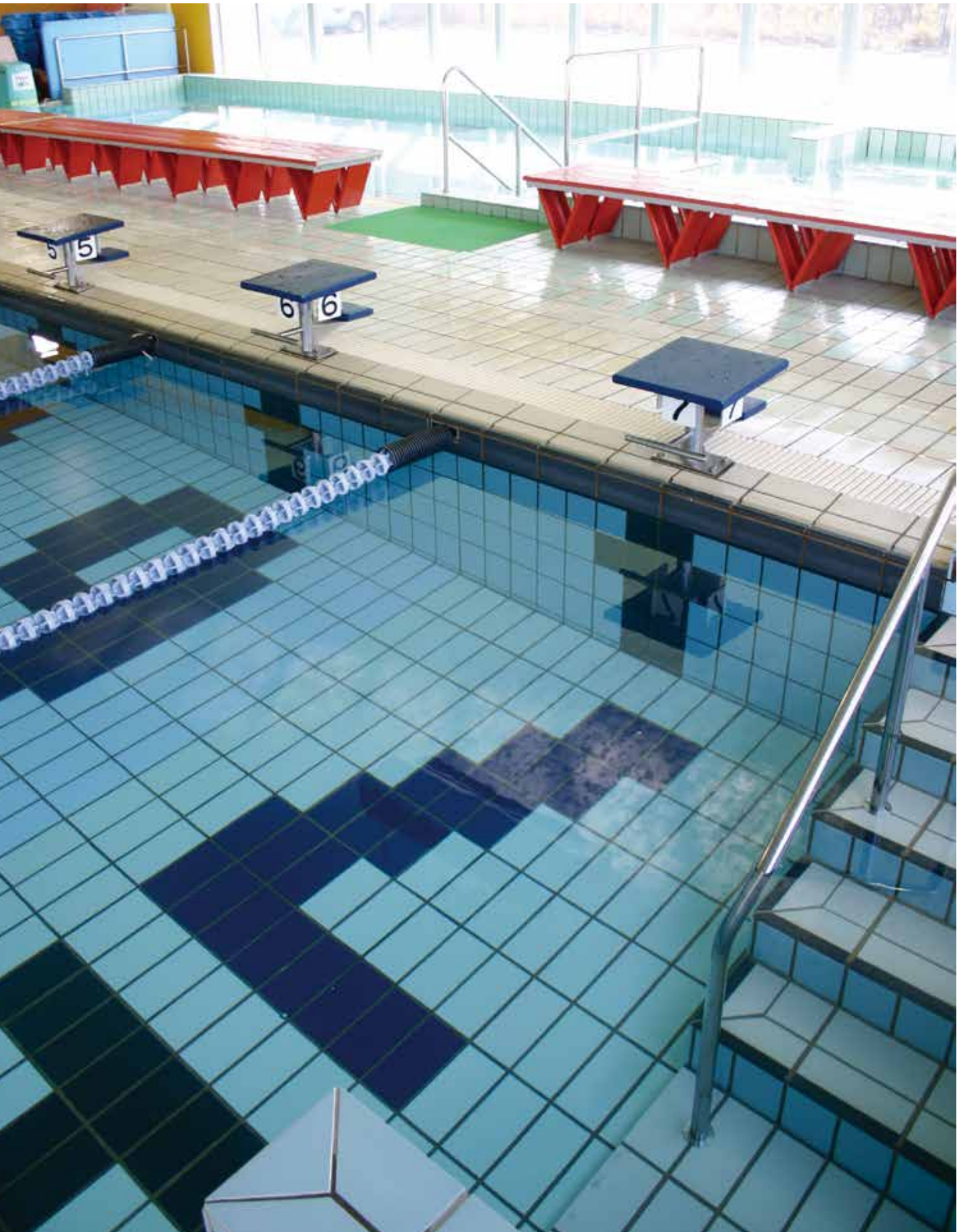
スウィン大教スイミングスクール 二本松校 施主:(株)大宮教育センター 設計:(株)VAN設計 施工:常磐開発(株) プール槽内:125×250角プールタイル
