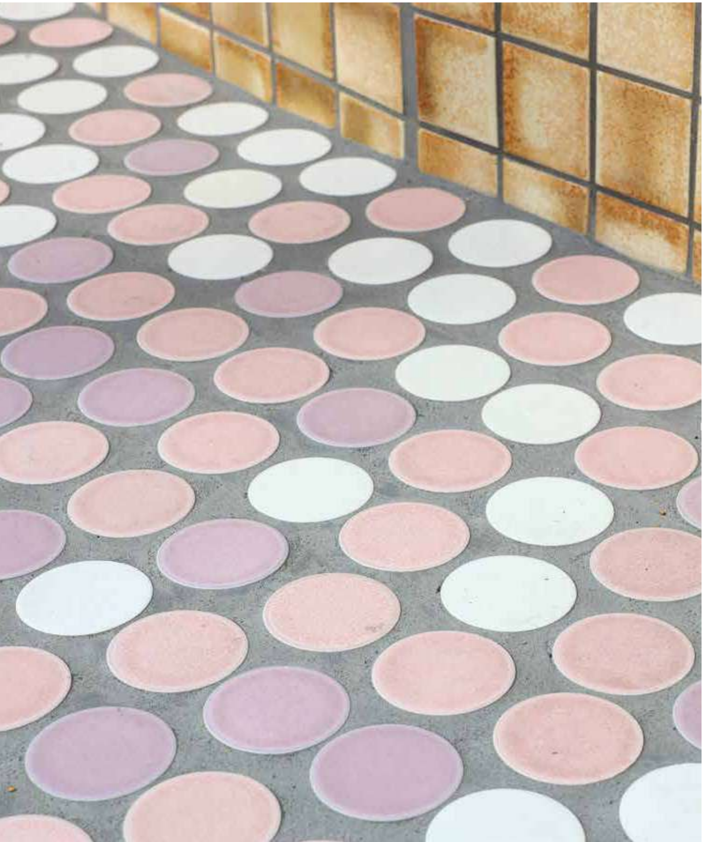
多治見市大藪町ラウンドアパート
