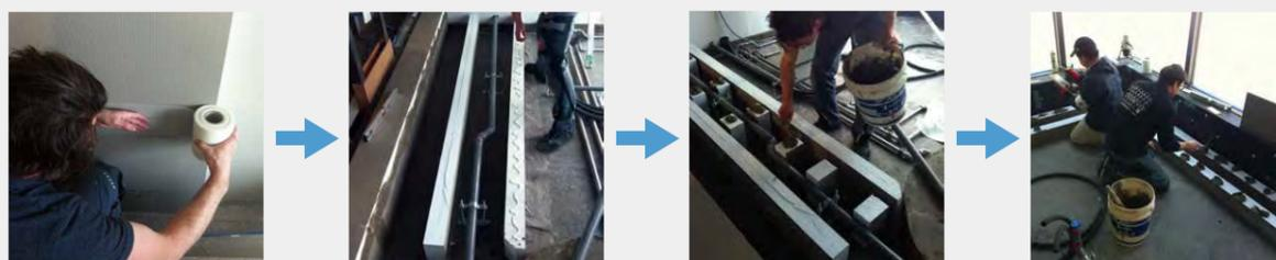
袖壁や間仕切の下地はもちろんのこと、床面にも使用できます。新設した給排水管に沿って補強をし床面のレベルを揃えます。
