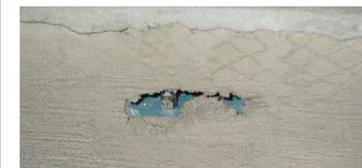
ペンキを剥がし、ステンレスを貼り樹脂モルタルで補強する
