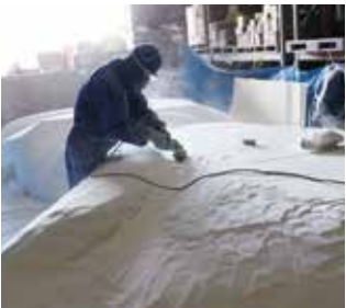
EPS躯体の手削り作業
