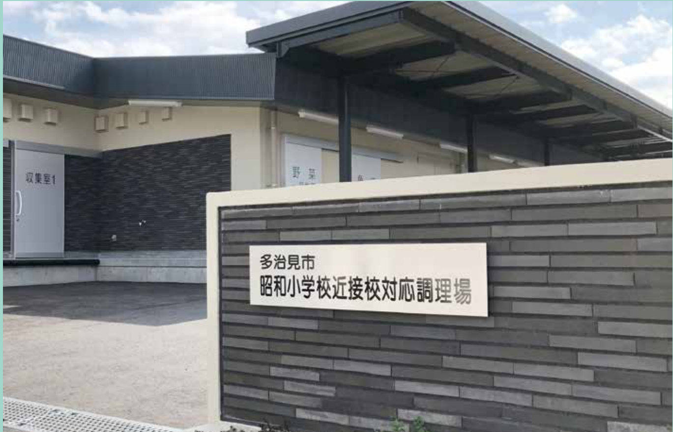
多治見市立昭和小学校 リサイクル原料:溶融スラグ
