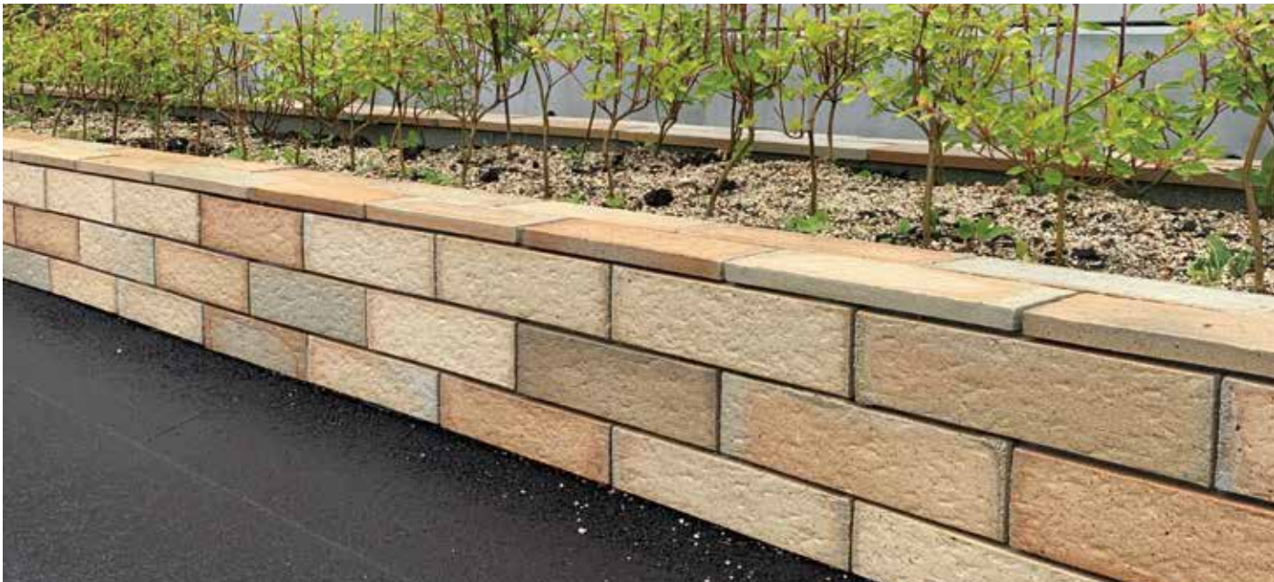
ダイニチ株式会社 岡山工場 アルミニウムを溶解する際の副産物である「アルミ灰」を再利用したリサイクルタイル。
