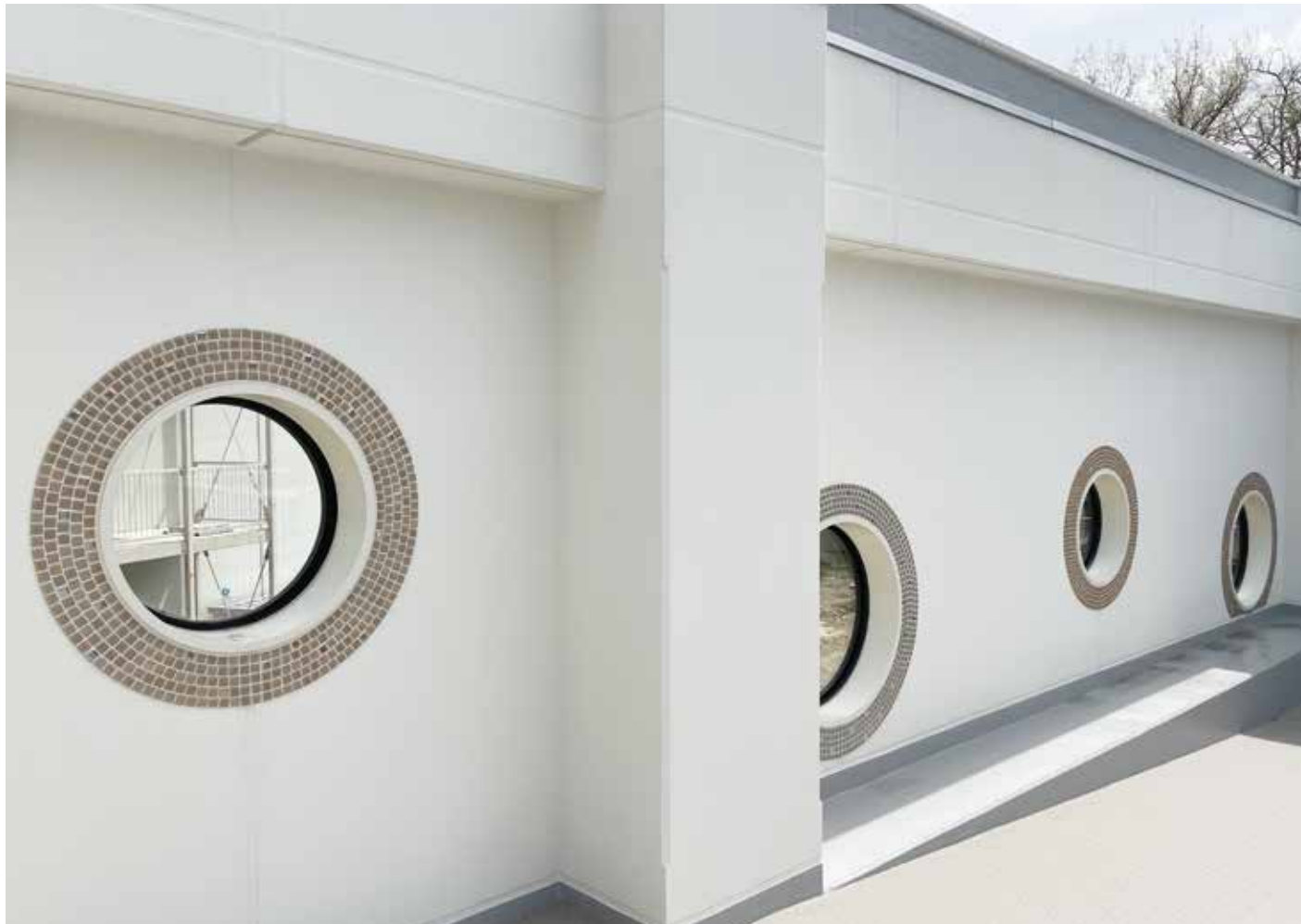
多治見市小泉小学校 設計:青島・日比野設計共同体 施工:岐建・吉川・加藤共同体
