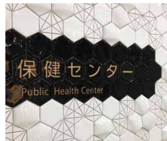
多治見市役所駅北庁舎内 保健センター 彫込部:上絵付技法 金彩
