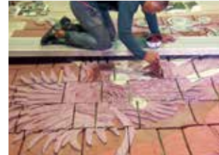
施釉作業（手作業にて釉薬だみ込み）
