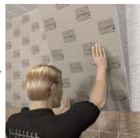
2 既存壁の上からパネル貼付け。
