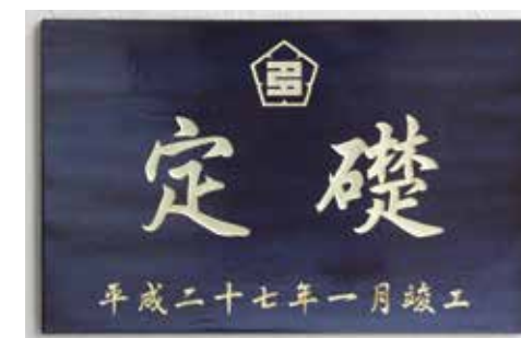
特注タイル 300×450mm 彫込部:油性塗料着色
